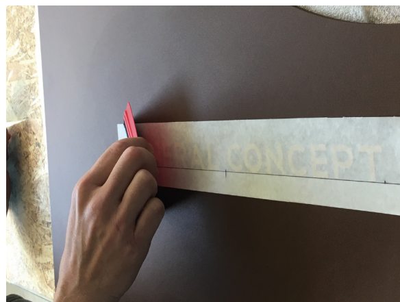
6 - REPASSER LA RACLETTE CÔTÉ MOUSSE SUR LE TRANSFERT PLUS FERMEMENT.
