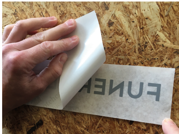
2 - RETIRER LE PAPIER SILICONÉ EN LE FAISANT GLISSER À PLAT (ÉVITER DE LE TIRER VERS SOI) ET LE CONSERVER. VEILLER À NE PAS POSER LES DOIGTS SUR LA PARTIE COLLANTE DE L'ADHÉSIF.
